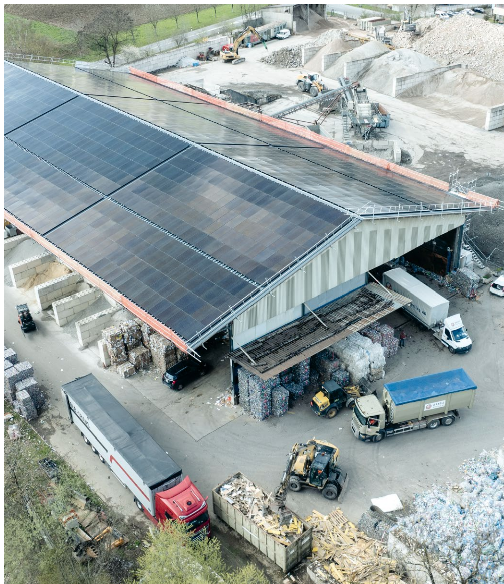
Il capannone a Birr è enorme – la superficie del tetto di 2000 metri quadrati è ricoperta da pannelli solari.
