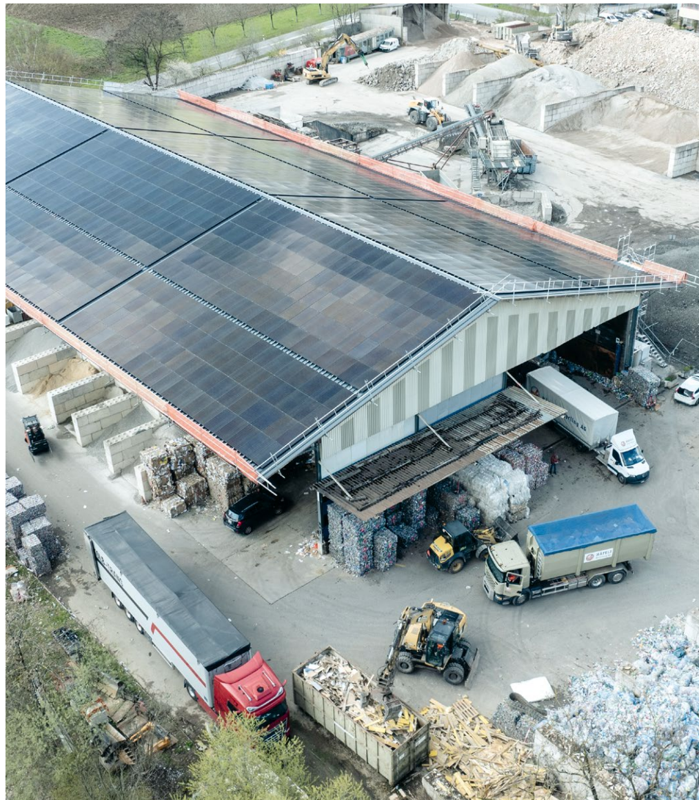
Die Halle in Birr ist riesig, das rund 2000 Quadratmeter grosse Dach ist bedeckt mit Solar-Panels.
